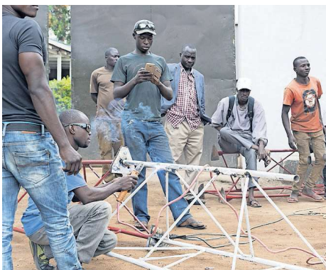
De antenne voor het radiostation wordt in elkaar gelast
